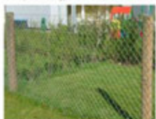
1. Clôture en fil de fer galvanisé du type simple torsion avec piquets en bois d'acacia
